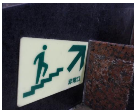
蓄光式誘導標識
